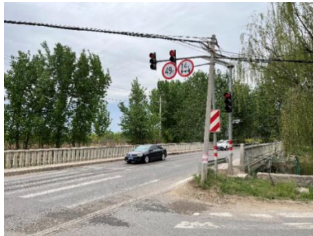
图 21 现状青礼路与小龙河相交处跨河桥
