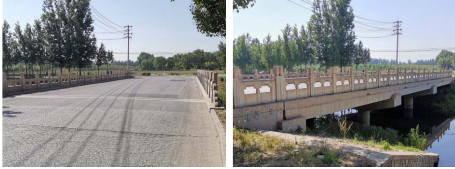
图 20 现状庞青路与小龙河相交处跨河桥
