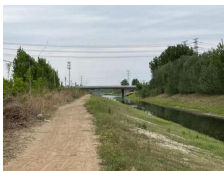
图 19 现状京台高速公路与小龙河相交处跨河桥
